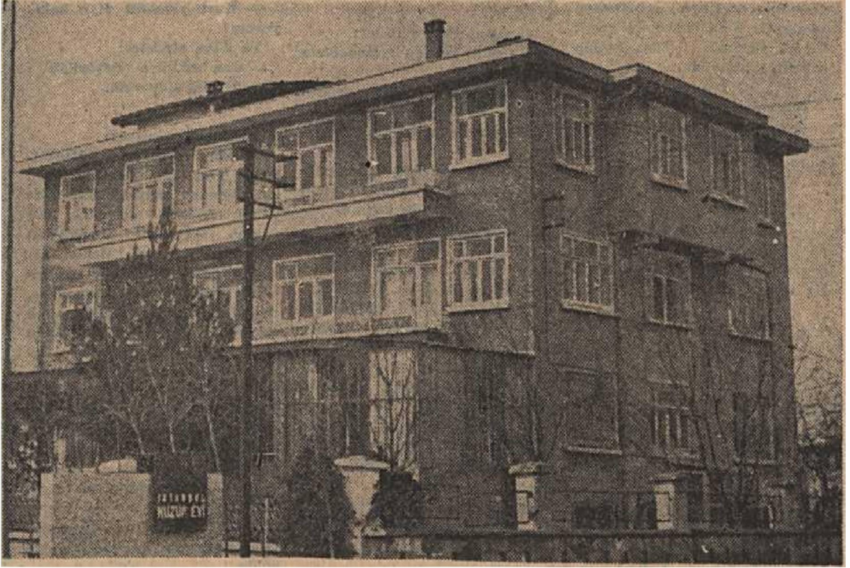
Kadın Şair ve Romancımız Şükûfe Nihal'in Bakırköy'de kaldığı Huzur Evi'nin dışardan görünüşü. Şükûfe Nihal huzur evinde bu evde çalışıyor.
